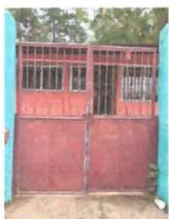
Foto 5: Mantenimiento a portón de ingreso, material: metálico, incluye: bisagras y sistemas de cierre.
