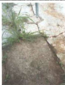
Foto 3: Reparación de losa de concreto para patios, considerando preparación de terreno, armado, nivelación y acabado rustico.
