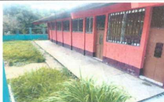
Foto 6: Sustitución de pintura de muro de interiores y exteriores del establecimiento.
